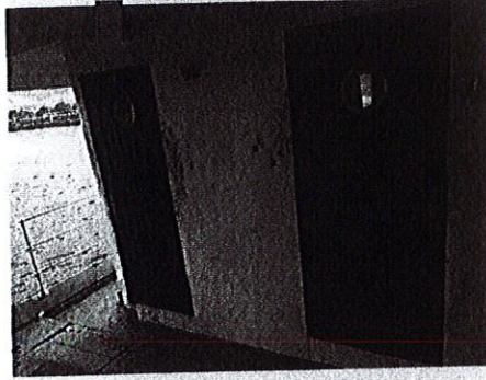
İskele WC Dış Görünüş
